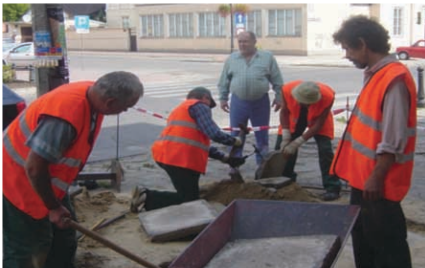
Remont chodników przed urzędem pracy.
