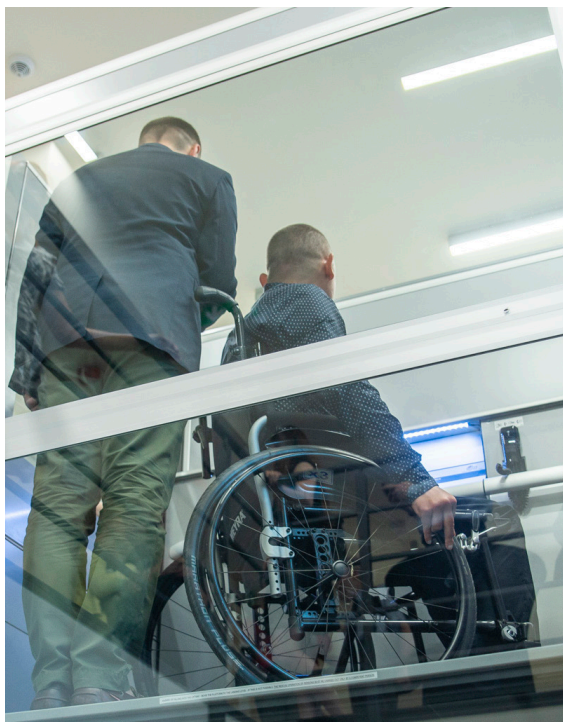
W budynku zainstalowano podnośnik kabinowy
